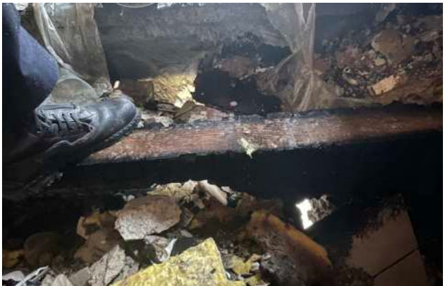
Geöffnete Holzdecke nach einem Brand innerhalb der Deckenkonstruktion (Foto: Reick; 08.04.2023)
