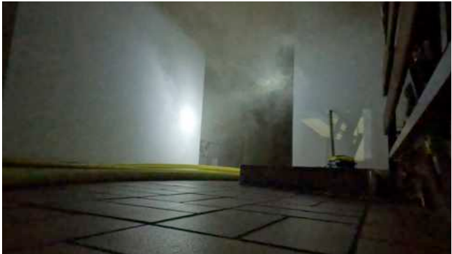
Rauchausbreitung in den Treppenraum bei einem Brand in einem achtgeschossigen Wohnblock (Foto: Reick, 04.12.2021). Der vorbeugende Brandschutz versucht durch entsprechende Vorschriften einer Verrauchung von Rettungswegen entgegenzuwirken. Die Arbeit der Feuerwehren darf dieses Bemühen durch geöffnete Türen nicht entgegenstehen. Vorbeugender und Abwehrender Brandschutz müssen sich daher gegenseitig unterstützen.
