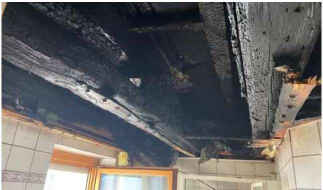
Geöffnete Holzdecke nach einem Brand innerhalb der Deckenkonstruktion (Foto: Reick; 08.04.2023)
